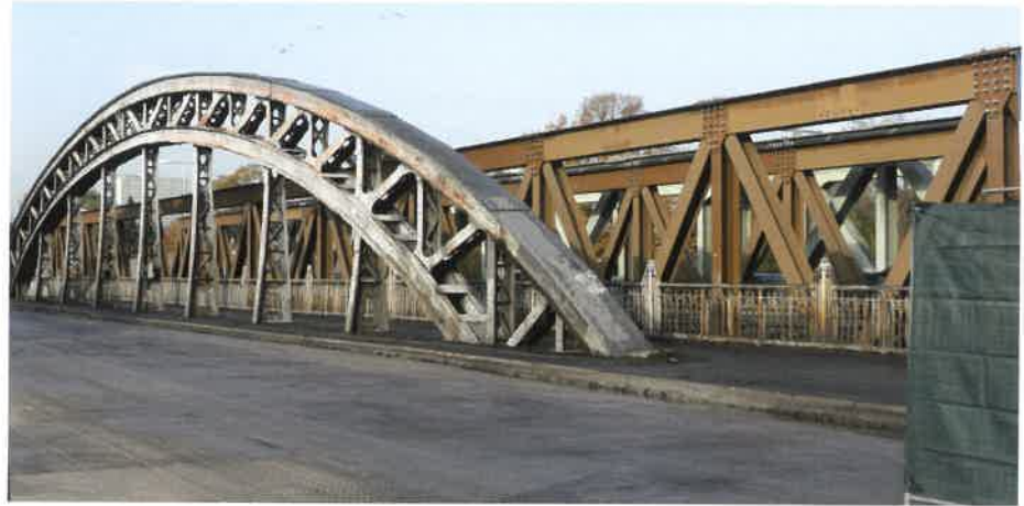
Bestandsbogen und Systembrücken der Behelfsumfahrung
