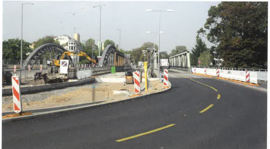
Verschwenkung der Heerstraße auf die Behelfsbrücken
