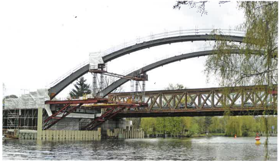
Bogenmontage mit Hilfe aufwendiger Traggerüste
