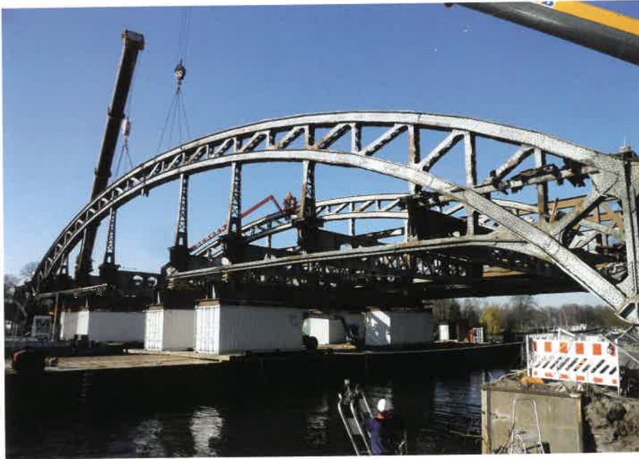
Demontage der Bestandsbrücke mit Pontonunterstützung
