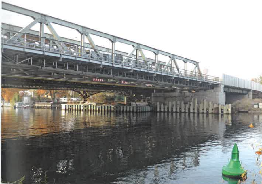
Stromfeld und westliche Vorlandbrücke der Behelfsumfahrung
