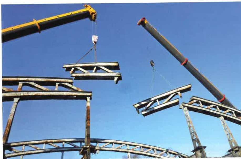
Ausbau des Bogenscheitels
