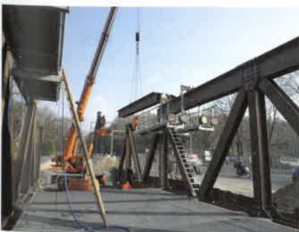
Montage der Systemfachwerkbrücke SS80
