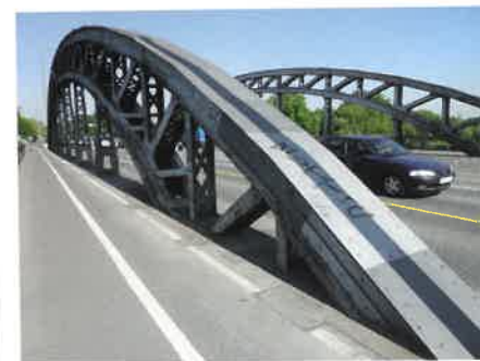
Fachwerkbögen des Bestandsbauwerkes
