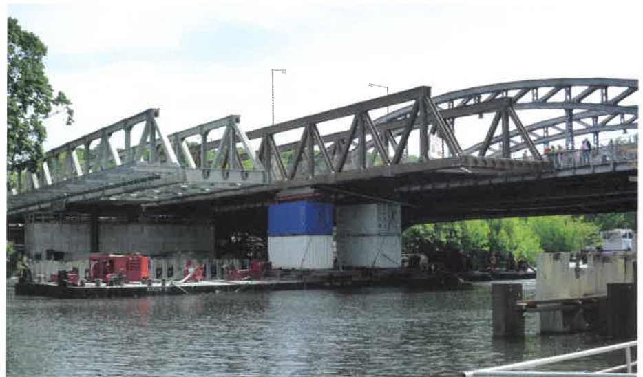
Einschub der SS80 mittels Ponton
