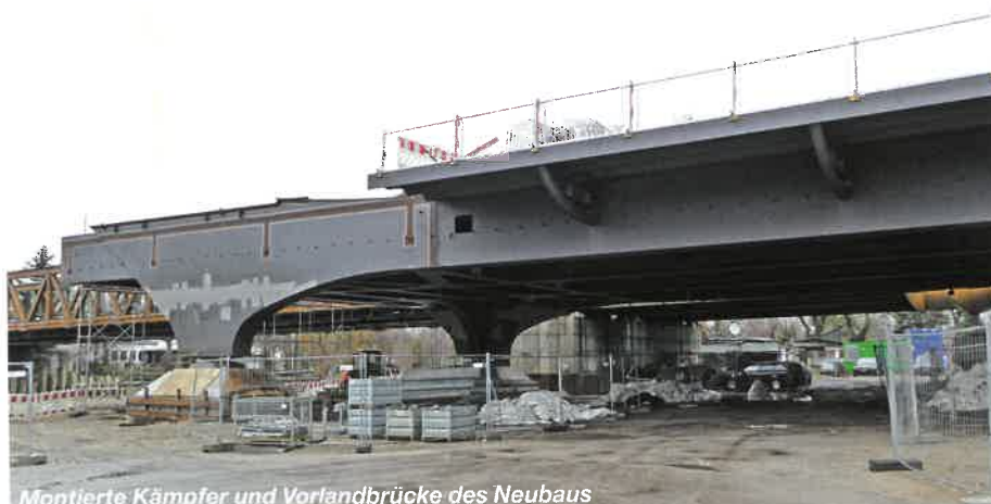
Montierte Kämpfer und Vorlandbrücke des Neubaus
