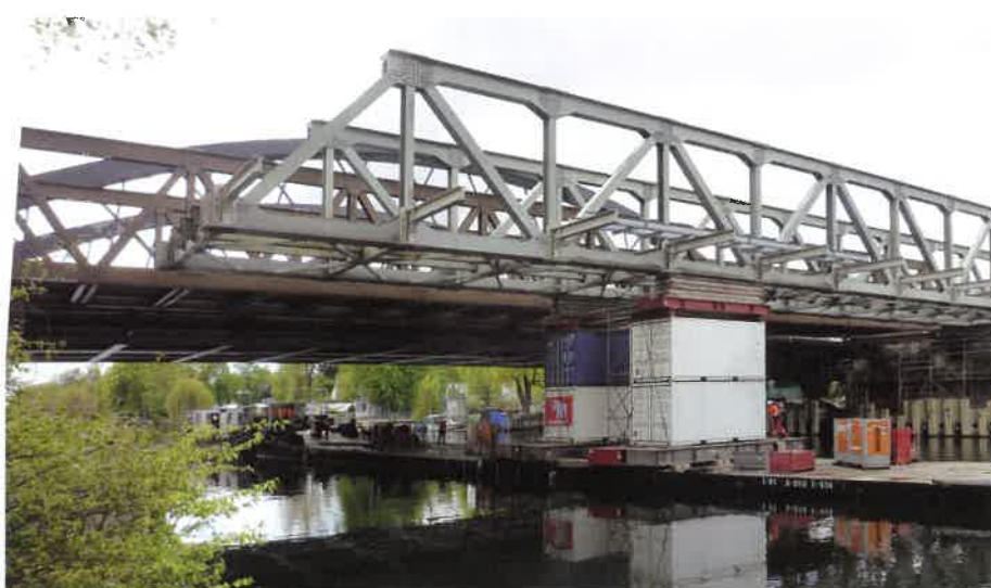
Ausschwimmen der Systembrücke SKB
