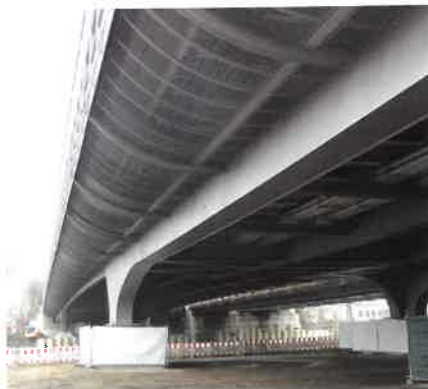
Vorlandbrücke mit unterseitiger Verkleidung der Gehwegkonsolen
