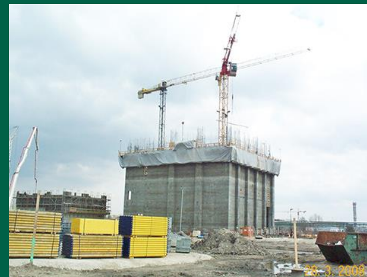
Gleitschalung Brennstoffbunker TRB Bitterfeld, 2009
