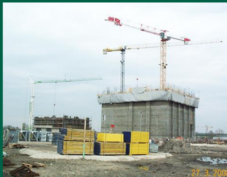
Gleitschalung Brennstoffbunker TRB Bitterfeld, 2009
