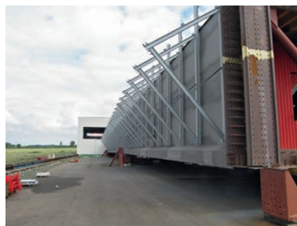
Bild 17. Windverkleidung Fig. 17. Wind-cladding
