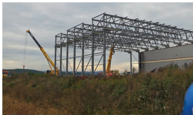
Bild 8. Aufbau der Einhausung für den Baustellenkorrosionsschutz Fig. 8. Housing for the painting works
