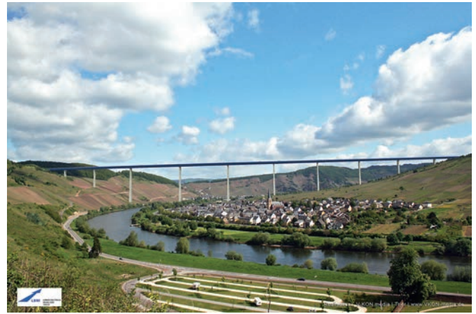
Bild 33. Fertiges Bauwerk Fig. 33. Finished construction
