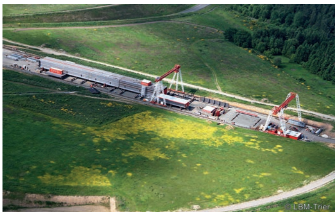
Bild 7. Luftaufnahme des Vormontageplatzes Fig. 7. Aerial view of the assembly-place
